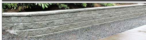
CMU RETAINING WALL SCALE: N.T.S.
