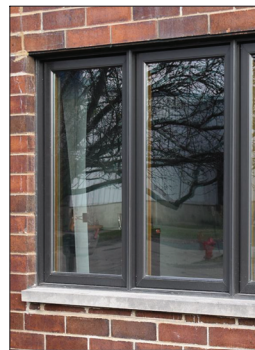
CASEMENT WINDOW SCALE: N.T.S. ALUM. FRAME, THER. DBL. PANE
