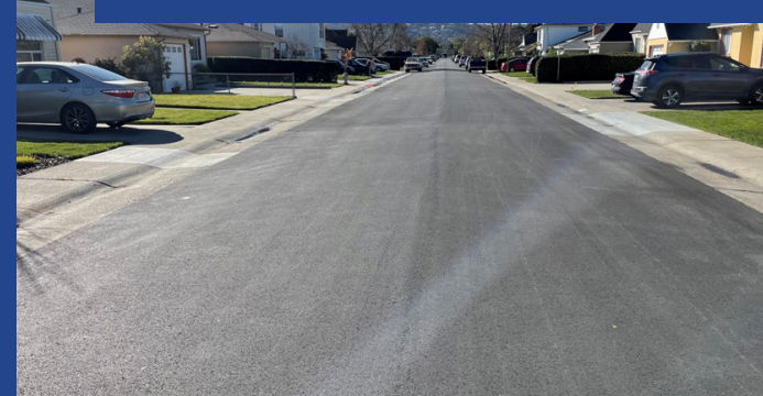
圖 2: FDR 完工與新瀝青鋪面
