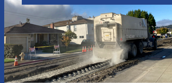
Figura 1: Proceso FDR Durante la Construcción
